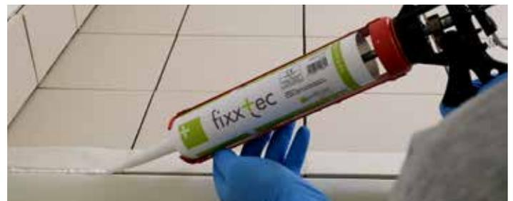
11\_ I punti di giunzione tra profilo bordertec e la piastrella possono essere eseguiti con il sigillante multiuso **FIXXTEC**.
