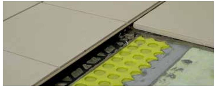
10\_ Distribuire l'adesivo cementizio riempiendo le cavità di **FLOORTEC**, pressandolo con la spatola liscia; stenderlo poi con la spatola dentata e posare il rivestimento ceramico e il giunto di dilatazione, dove previsto.
