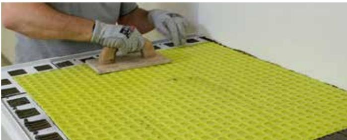
4\_ A l'aide d'une truelle en plastique, presser convenablement la membrane.
