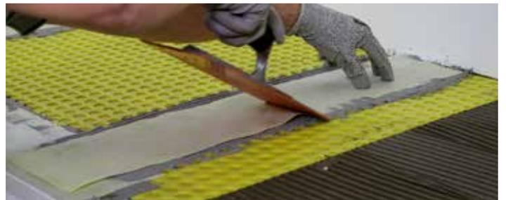
8\_ Appliquer **FOILTEC/15** pour étancher les joints et les chevauchements ; faire adhérer la membrane à la colle à l'aide d'une truelle en plastique.
