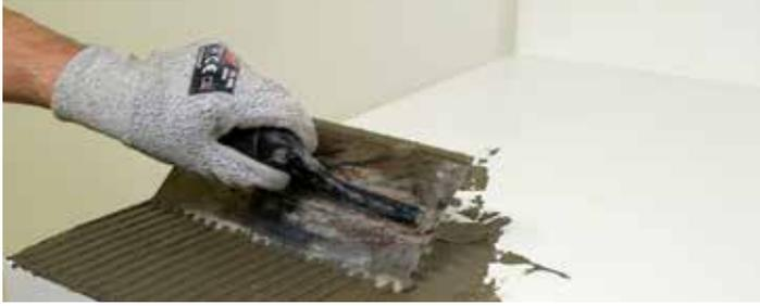
1\_ Le support doit être porteur, plat, propre et sans aspérité. Étaler le ciment colle à l'aide d'une truelle dentelée de 6x6 mm.
