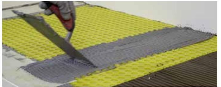
7\_ Veiller à niveler la colle **KOLLTEC** et à remplir complètement les cavités cylindriques de la membrane à l'aide d'une truelle lisse, puis d'une truelle dentelée appropriée (3x3 ou 4x4mm).
