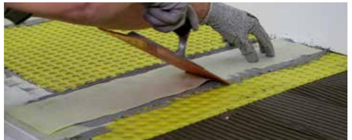
8\_ Appliquer **FOILTEC/15** pour étancher les joints et les chevauchements ; faire adhérer la membrane à la colle à l'aide d'une truelle en plastique.
