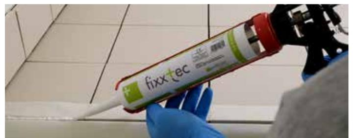
11\_ Les joints entre le profilé bordertec et le carrelage peuvent être réalisés avec le mastic polyvalent **FIXXTEC**.
