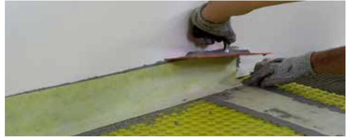
9\_ Dans les volets périphériques, la bande s'étend sur 10 cm verticalement (bord du mur) et sur 5 cm horizontalement (sol).
