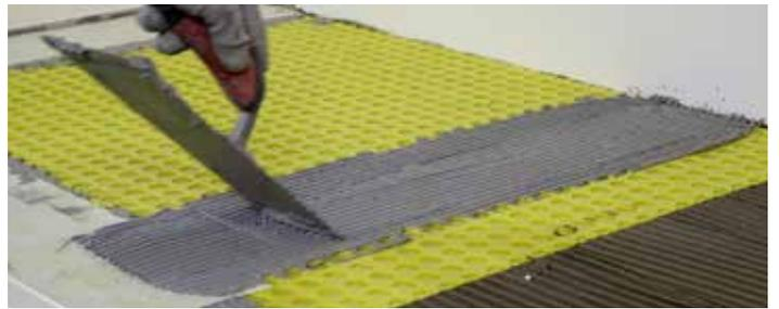
7\_ Asegúrese de nivelar el adhesivo **KOLLTEC** y rellenar completamente las cavidades cilíndricas de la membrana con una llana lisa y, a continuación, con una llana dentada adecuada (3x3 ó 4x4mm).
